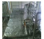
ボイラー上部
